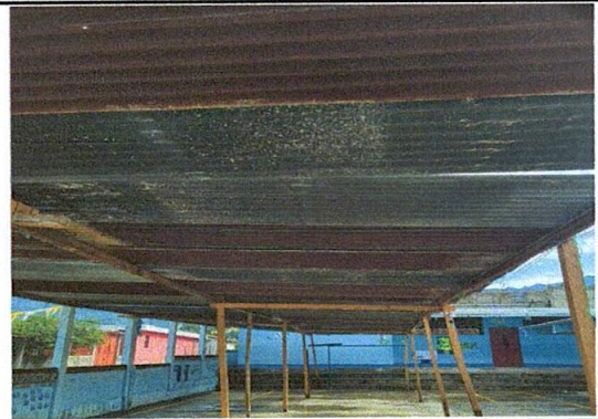
Foto 4: fotografia techo cancha
